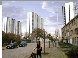
appartementen te Antwerpen transformatie 3 woontorens uitvoering: 2004-2009
