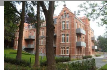
renovatie voormalige psychiatrische instelling appartementen in paviljoenenbos uitvoering: 2009-2012
